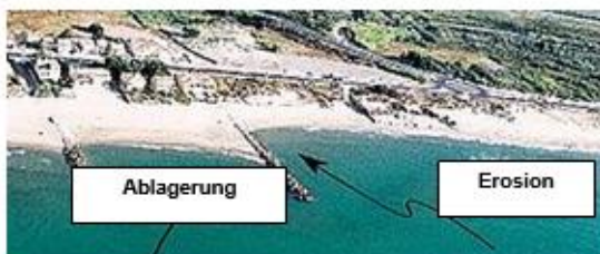
Dokument 12.43. Bild mit Ablagerung und Erosion
